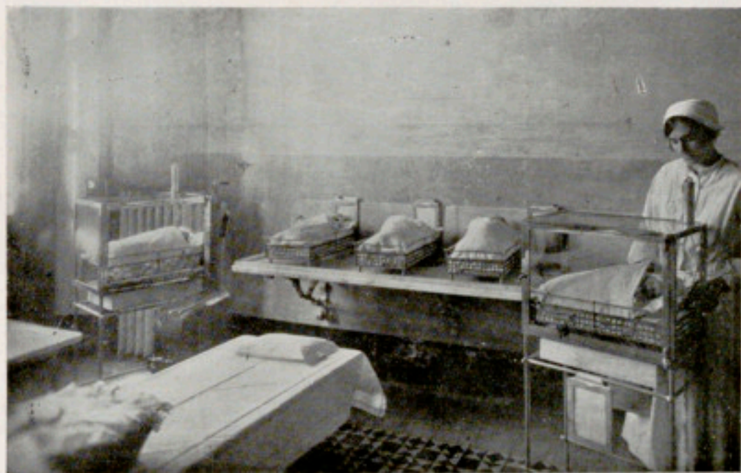
Detalle de la misma
